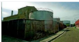
Antiga central d'energia de Seat, a prop de la Ronda Litoral, on s'aixecarà la nova planta, ahir. Foto: JOAN CORTADELLAS
